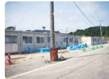
仮設住宅建設（7月30日入居）
